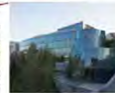
Meudon Campus Pei Cobb Freed & Partners M. Macary 45 000 m 2 Livraison: Janvier 2007 Utilisateurs : Gemalto - SFR
